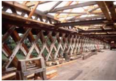
写真 31：イスイエル・タウンの ラチストラス (1820 年特許取得)
