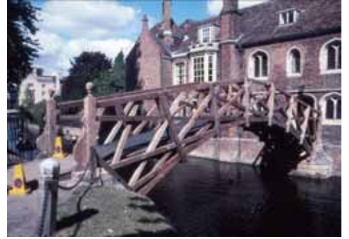
写真 18：マスマティカル橋 (1749 年建設)
