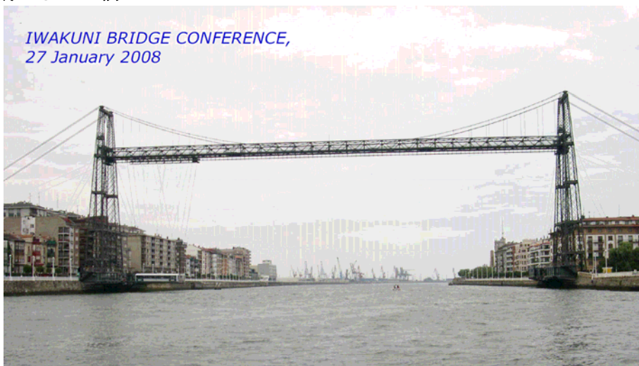
運搬橋：高い桁橋と長い径間
