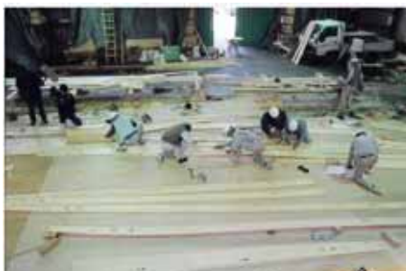
写真-3・4 型板作製
