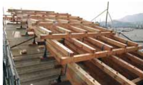
写真-10 5番桁からは、桁尻を前へ前へと迫り出して組み上げる
