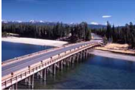
写真 48：フィッシング・ブリッジ (1937 年建設)
