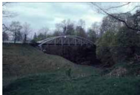
写真13: ホイップルの鉄製 ボーストリングトラス橋 (1867年建設)
