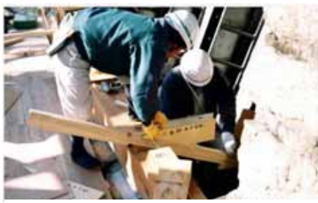
写真-9 最初の桁を取り付ける角度が橋の形態に大きく作用する
