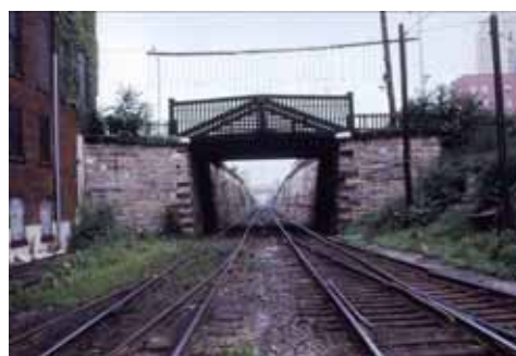
写真 25：レディング鉄道に架かる橋
