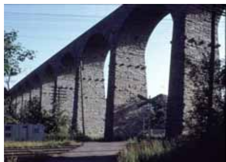
写真14: スタラッカ高架橋 (1848年)
