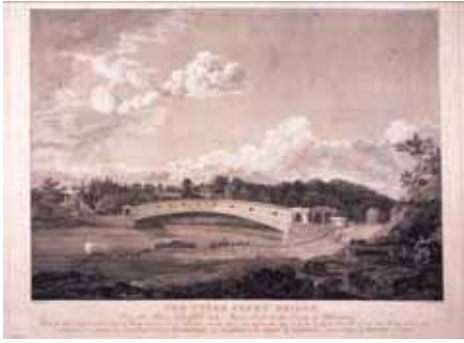
写真 30：アッパー・フェリー橋 (1812 年完成、1838 年焼失)
