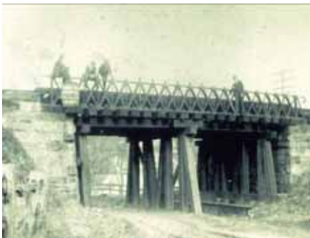
写真 42: マナユンクのトラス橋 (1845 年)
