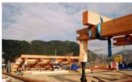
写真-11 9番桁間に大棟木の型板を当てて、距離を書き写す
