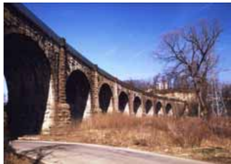
写真9: トーマス高架橋 (1835年建設)
