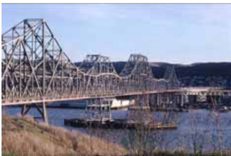
写真5：カーキネス海峡の橋（1927年建設、1958年再建、2003年移設）
