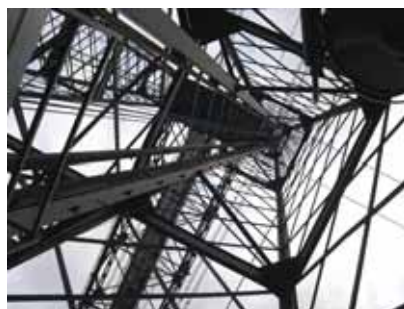
橋脚の内部構造
