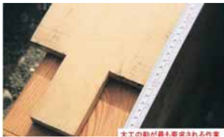
写真-12 経年変化による沈下量を考慮し、大棟木の長さを決定する
