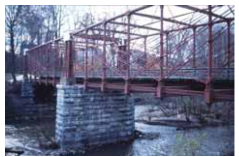
写真 46: ボルティモア・オハイオ鉄道の ボールマントラス橋 (1869 年)
