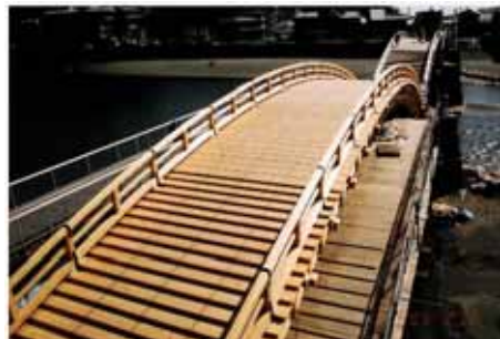
写真-15 アーチ橋完成
