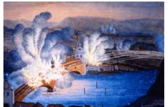
写真 21：爆破されるシャフハウゼン橋 (1799 年)
