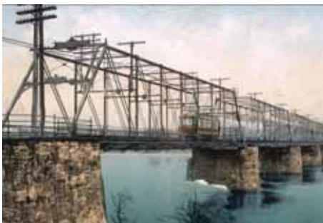
写真 44: カルホーンストリート橋 (1885 年建設)
