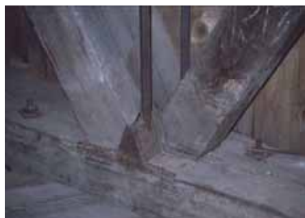
写真 35：鉛直材の定着部
