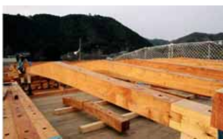
写真-13 大棟木取付完了
