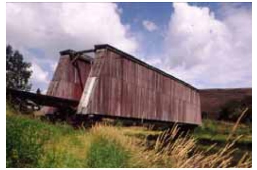
写真 39：ハーポール・マニング橋 （1922 年建設、1928 年再建）
