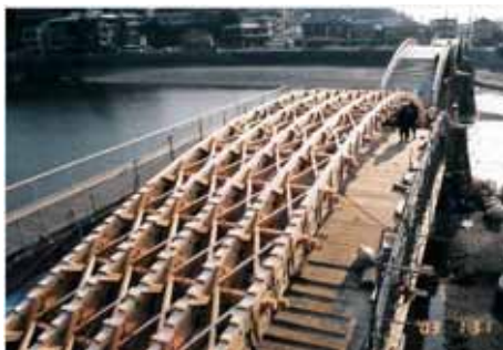
写真-14 補助部材(振止、助木、鞍木)、平均木取付完了
