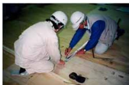
写真-1・2 現寸図作成
