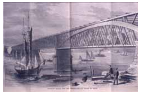
写真 36：サスケハナ川の木鉄混合橋 (1867 年建設)
