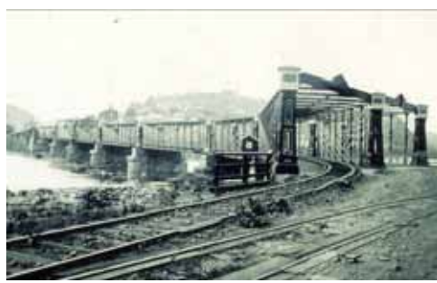
写真 45: ハーパーズ・フェリー橋 (1870 年建設)
