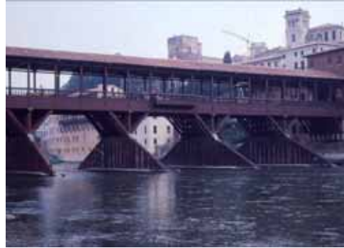
写真 17：アルビニ橋 (1569 年完成、1948 年再建)
