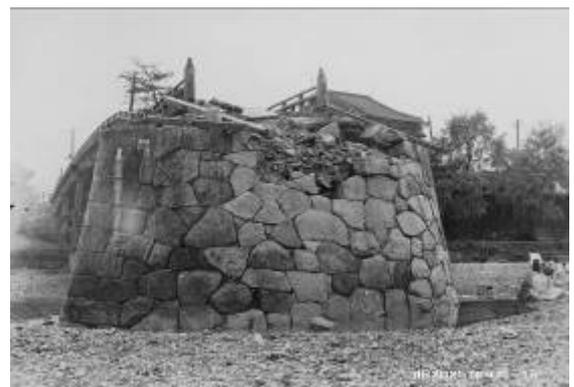
写真 - 5 キジア台風で崩壊した石組橋脚
