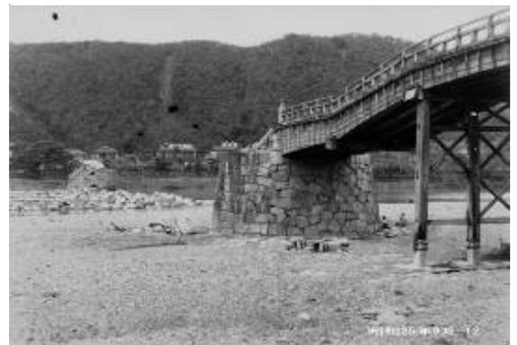
写真 - 6 キジア台風で流失した錦帯橋
