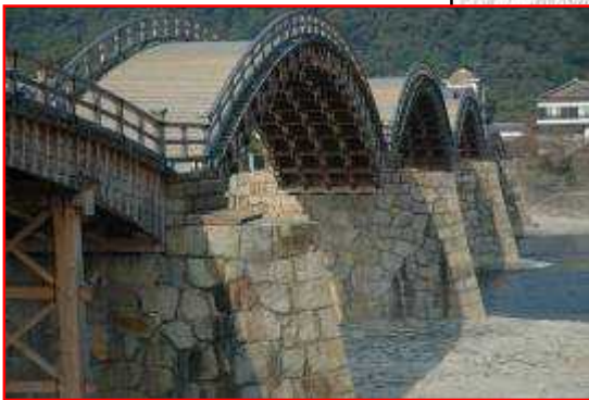
錦帯橋エリア
