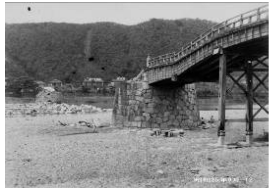
写真-9 キジア台風で流失した錦帯橋
