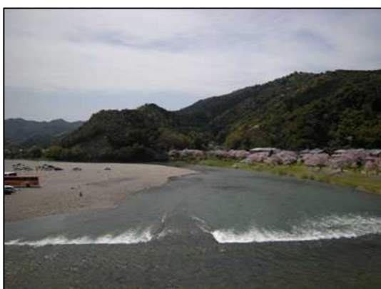
写真付-7 下流方向
