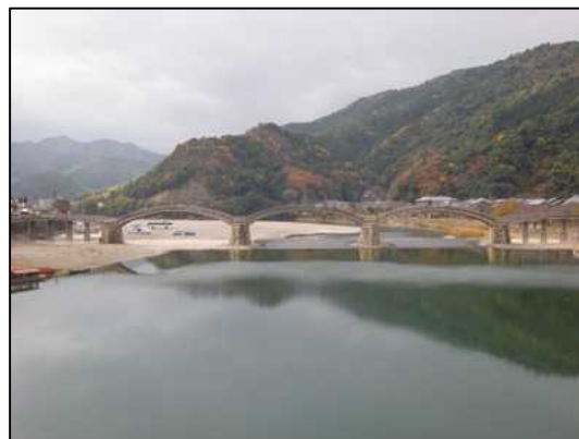
写真2-17 アルコーブから見た錦帯橋
