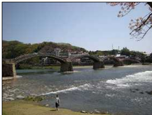
写真付-13 平成架替後(平成20年)の写真
