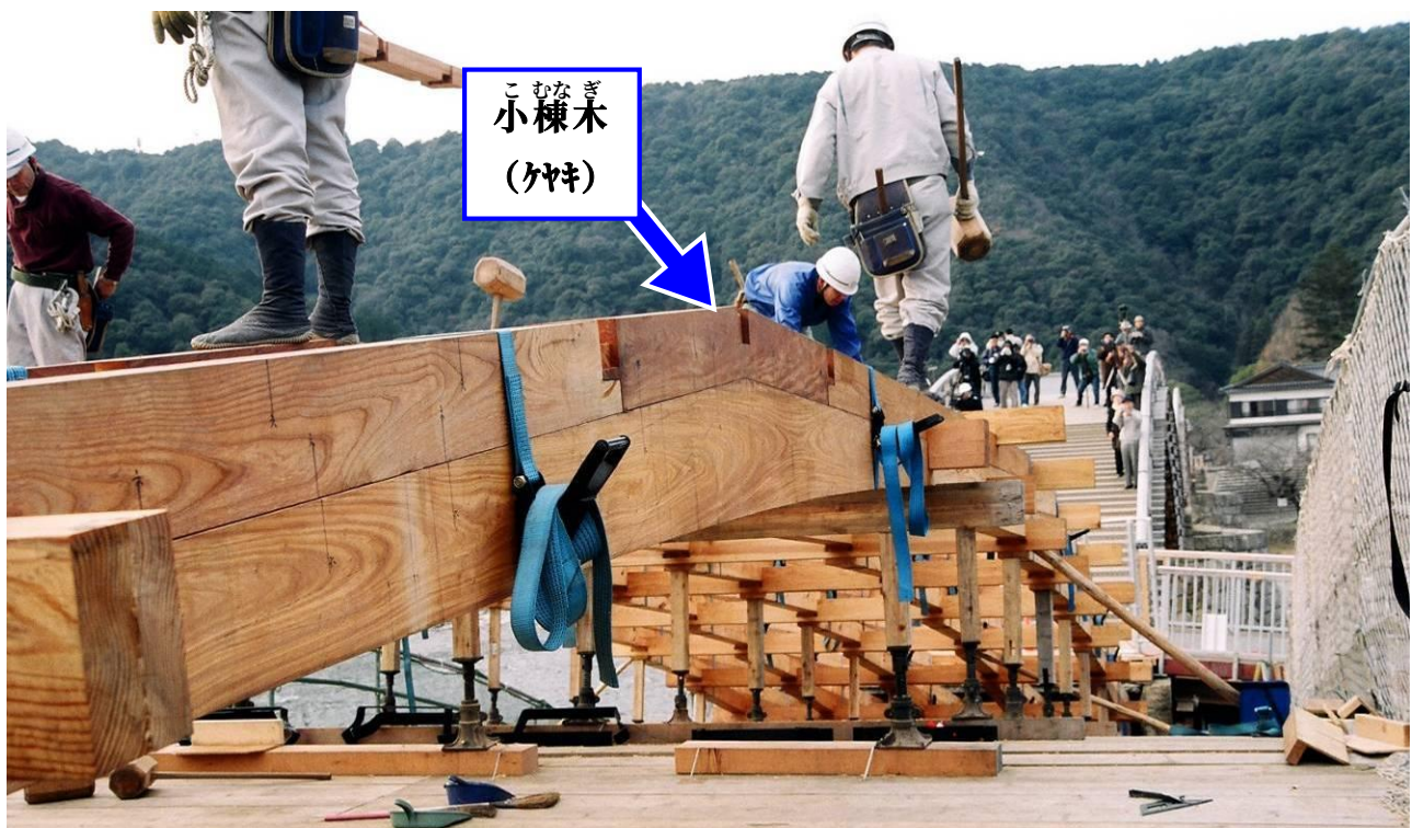
じゅうばんけた 十番桁の先同士をつなげるこむなぎ 小棟木を取り付けます。
