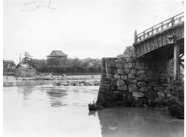
橋脚 2 基が崩壊し、アーチ橋 3 橋が流失した
