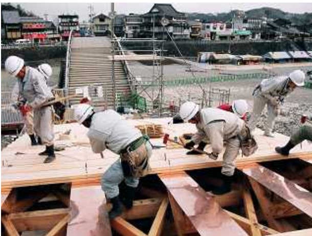
橋板に和釘を打っている様子
