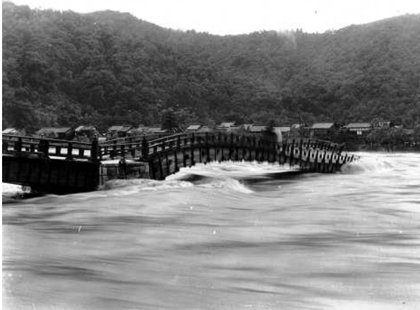
橋脚崩壊により流失する瞬間の第 2 橋
