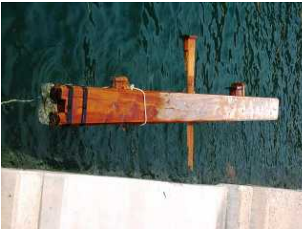
祝島沖で発見された流失橋杭
