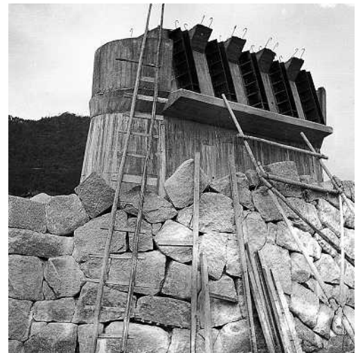
上 再建前の橋脚(差し込んだ桁が腐朽している) 下 再建によって鉄筋コンクリートになった橋脚と接合部の沓鉄
