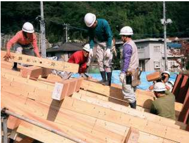
本工事前に地上で陸組（おかぐみ）を実施し、部材の調整を行った
