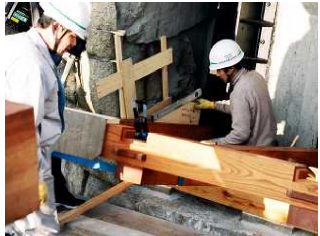
橋全体の高さが決まるため、最初の桁の取り付けには細心の注意が必要
