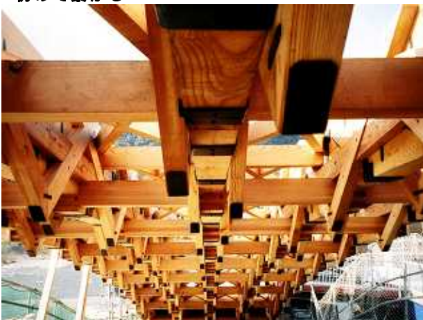
下方から見たアーチ橋の構造体
