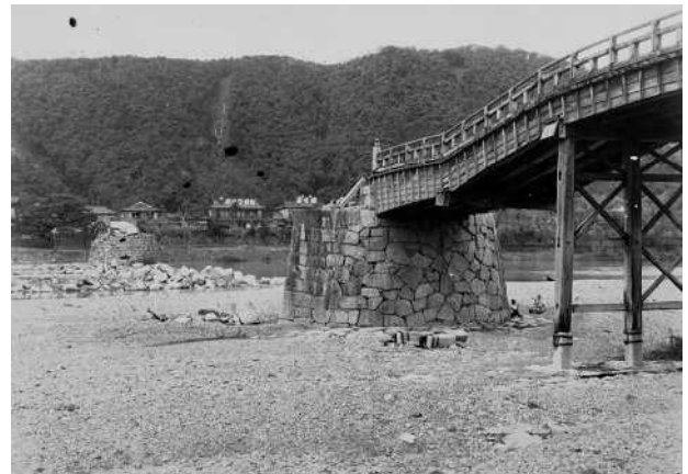
キジア台風の時も第一橋の第五橋杭が、最初に流失していたことが写真で判ります
