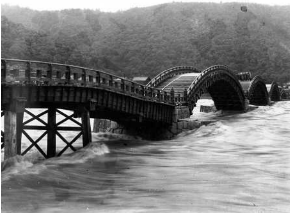
キジア台風の時も第一橋の第五橋杭が、最初に流失していたことが写真で判ります
