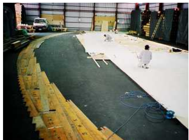
過去の型板をもとに原寸図面が作成された
