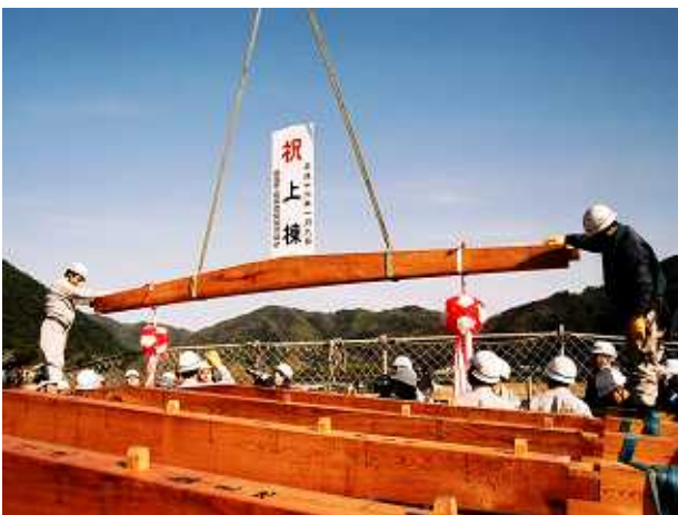
両側から伸びた桁材は大棟木を組み込むことで初めて繋がる
